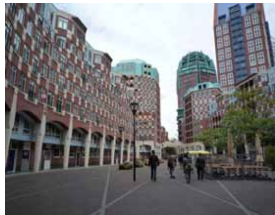
資料7 - 13 省庁街へ続く市役所横の 集合住宅
