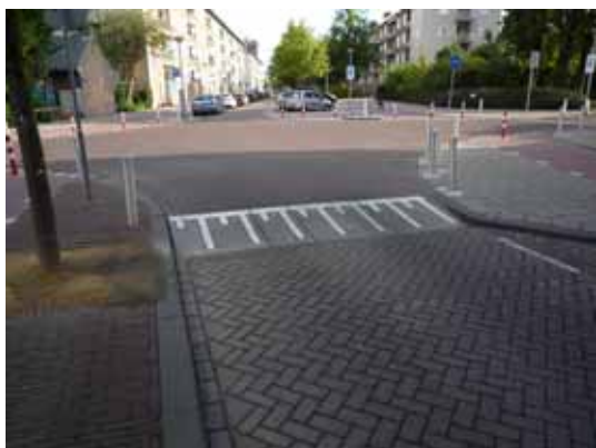
資料8 - 5 住宅地の交差点では必ず 見かけたサインハンプ。交差点全体が高くなっている
