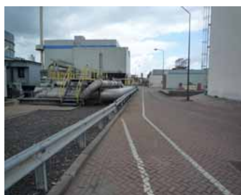
資料2 - 4 左奥は新設バイオマス発電
