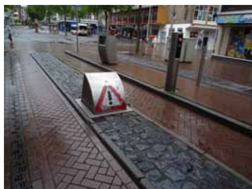
資料4 - 8・9 正午からは許可カードを挿入するか、管理者にモニターを通じ連絡し、車止めを下げてもらう。
